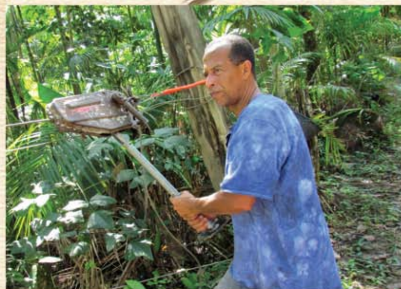
Esticando o cabo com o gancho tífior
